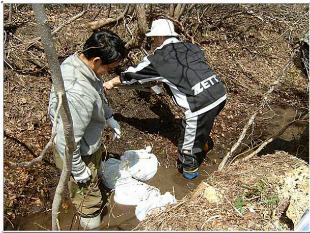
次々に土嚢が投げ込まれます。
