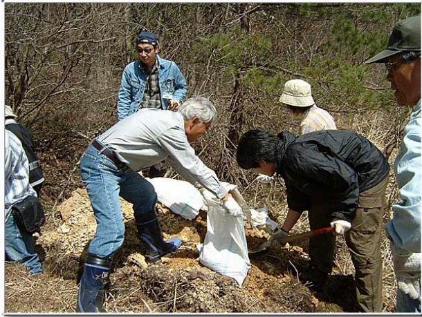
はじめに、土嚢を作って水流をせき止めます。
