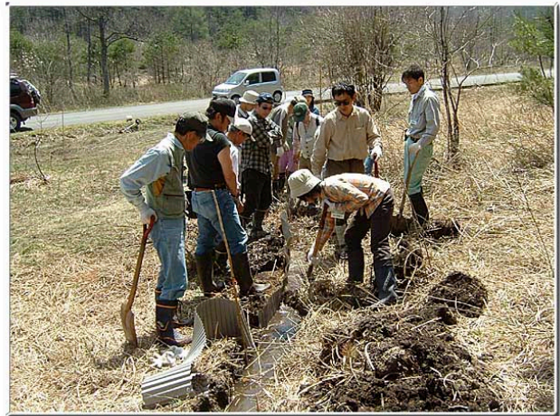
いよいよあぜ波を設置、水を流していきます。もれる所は補修し、流れないと掘ったりして調整しました。
